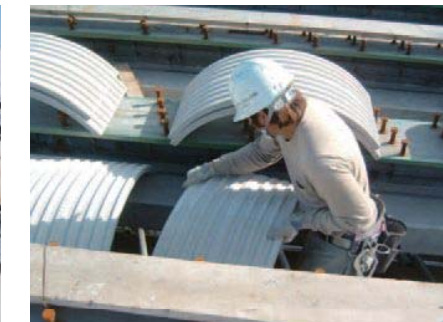
アーチフォームの敷設
