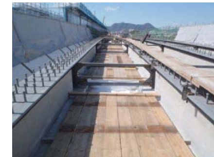
簡易足場の施工例
