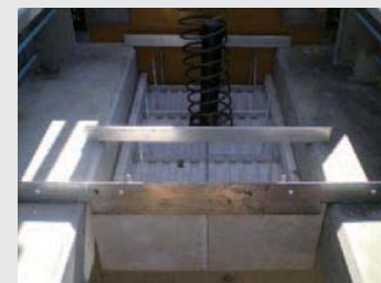
端横桁の施工
