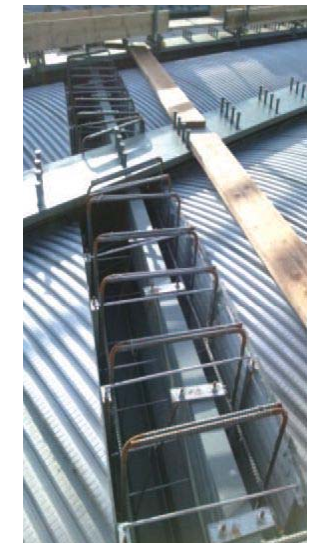
横桁の施工例
