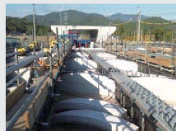
中間横桁の施工
